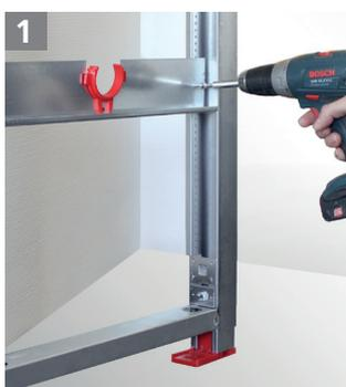
Alle Traversen sind von vorne mittels eines Kreuzschraubendrehers zu lösen, und auf das gewünschte Maß der Keramik einzustellen, und wieder zu fixieren.
