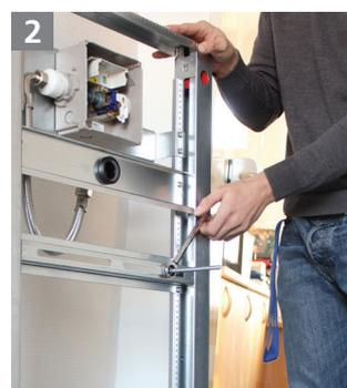
Gewindebolzen M8 von hinten durch die Traverse mit dem Langloch stecken, auf das gewünschte Maß ausrichten, und mit der beiliegenden Unterlegscheibe und Mutter kontern.
