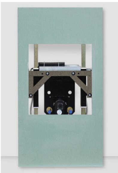
**10.** Wasseranschlüsse überprüfen und GKFI-Bauplatte anbringen
