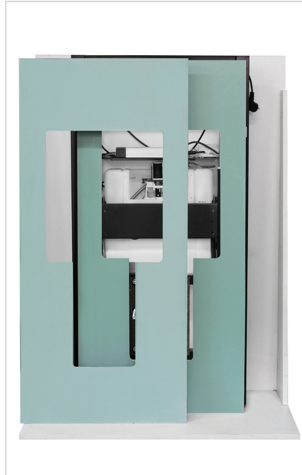
5. und die vordere GKFI-Bauplatte
