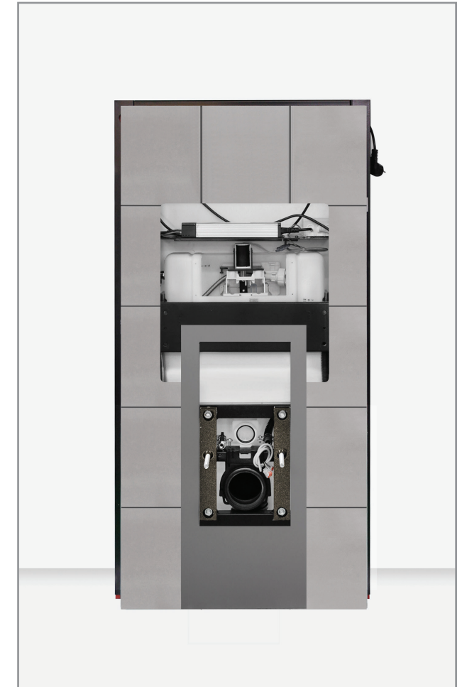
17. Schutzplatte mittig davorstellen (Bitte beim Fliesen keine Silikon- fuge am Boden ziehen!)
