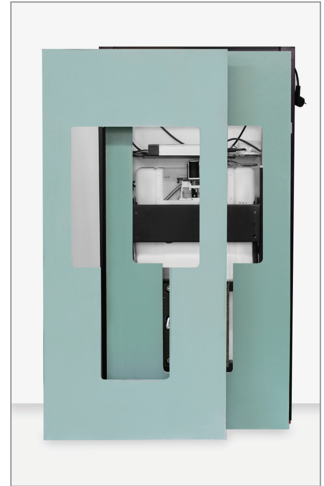
12. Beide GKFI Bauplatten übereinander anbringen (doppelt beplanken)
