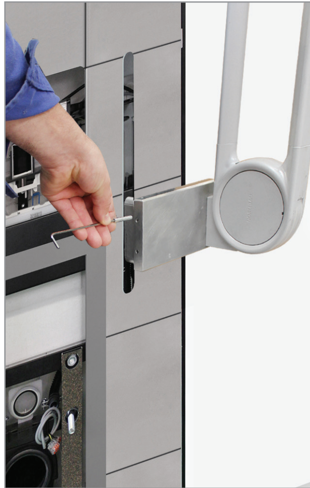
mit Schrauben befestigen
