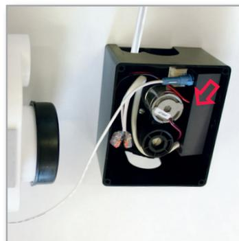
Elektronikbox in das Rohbauset einsetzen
