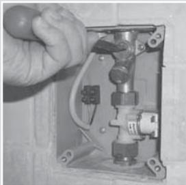
Elektronikplatte wie oben beschrieben abnehmen. Montagerahmen abnehmen. Achtung! Wasser- abspernung schließen.
