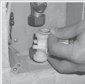
Neues Ventil einsetzen. Achtung! Neue Dichtungen oben und unten verwenden und Flussrichtung beachten.
