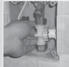
Magnetventil entnehmen. Dichtungen entfernen und erneuern .
