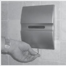
Sicherungsschraube unten mit Inbusschlüssel SW 2,5 öffnen und Gerät nach vorne abziehen
