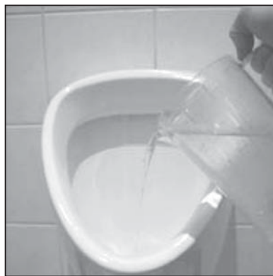
Funktion prüfen: mit Eingabe von 1l Wasser erfolgt eine Spülung
