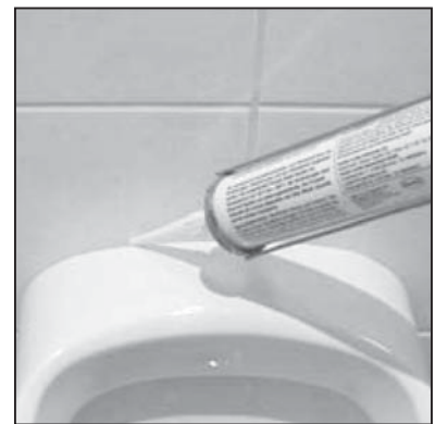
Wasserdichte Silikonverfugung rund um die Urinalkeramik herstellen
