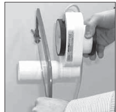
Länge des Sensorsiphons an den Ablauf anpassen
