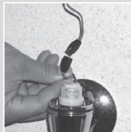
Kabelverbindung zum Magnetventil vorsichtig trennen.
