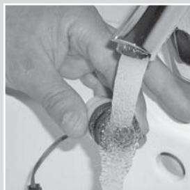
Schmutzfilter mit Wasser und kleiner Bürste reinigen, ggf. Ventil tauschen.
