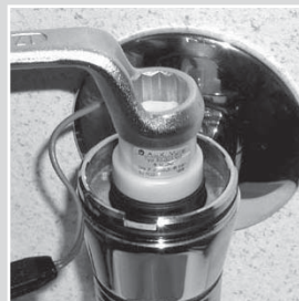
Magnetventil mit Ringschlüssel SW 17 vorsichtig öffnen.
