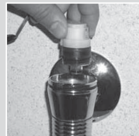
Das letzte Stück das Magnetventil mit der Hand herausschrauben und entnehmen.
